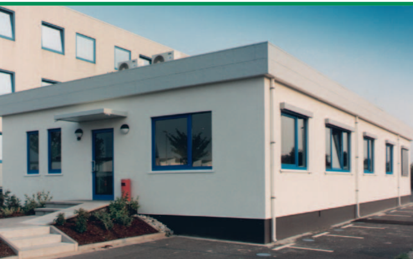
vorher (eingeschossiges Gebäude)
